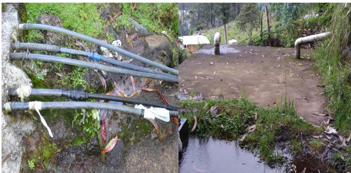
Figura 42: a. Domiciliarias de distribución a cada beneficiario.
