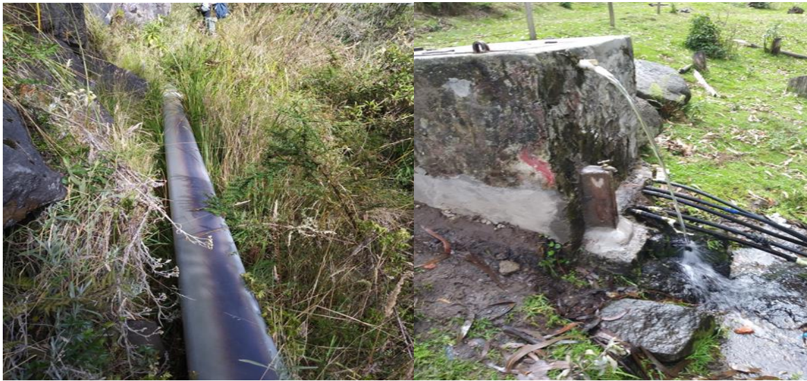
Figura 44: a. Tubería en zona de riesgo por movimiento de masas. b. Agua que se pierde constantemente.
