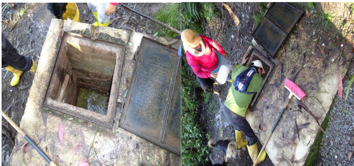
Figura 41: a. Cámara rompe presión.
