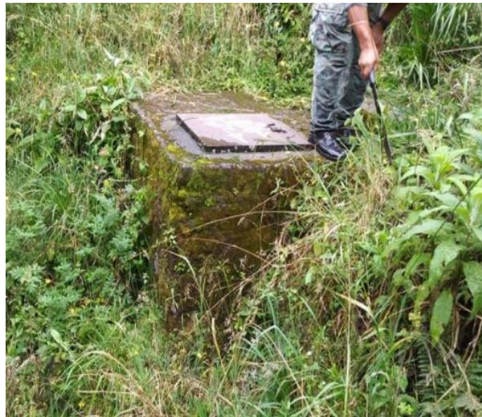
Figura 38: Cámara rompe presión. Elaborado por: Autor. 02 de junio del 2019.
