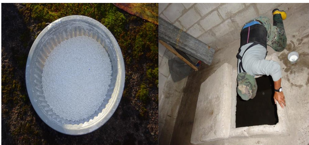
Figura 40: a. Dosis de Hipoclorito de Sodio ( \text{NaClO} )
