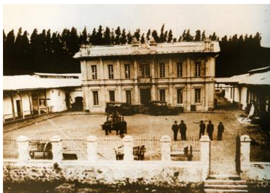
Figura 9. Fotografía de la Hacienda Santa Clara del libro “Progreso Centenario 1892-1992”
