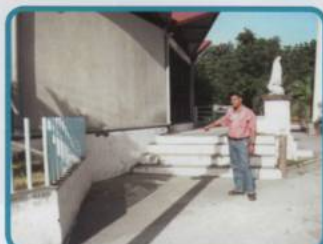
Iglesia sin arteria para las PCD, debido a la presencia de gradas que imposibilitan su acceso.
