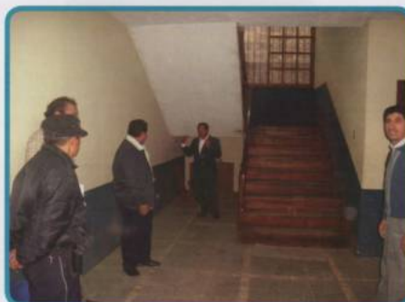
Interior de las oficinas del Registro Civil sin accesibilidad para las PCD. Se observan las gradas que impiden acceder a las dependencias que están en el piso superior.
