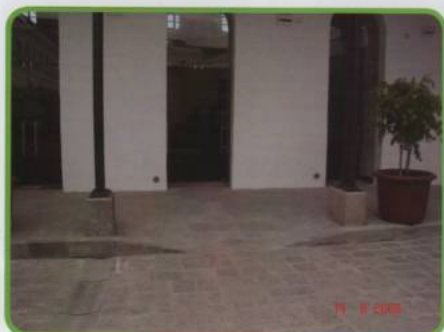
Rampa de menor longitud que facilita el paso a las personas con discapacidad.
