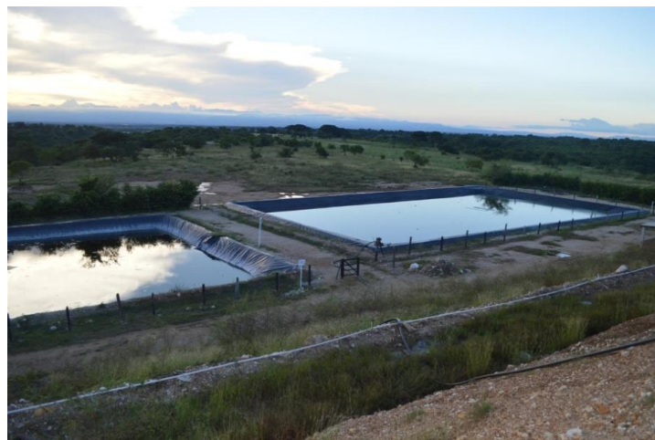
Foto 12 Piscinas de oxidación Fuente: google.com Elaborado por: Autor del Proyecto
