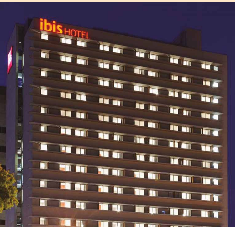
Primer Hotel de la cadena Ibis en la ciudad de Quito (en construcción).
