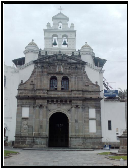
Fachada de la iglesia de Guápulo
