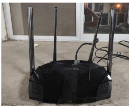
Figura 31. Instalación del Router.
