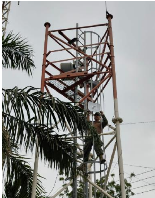
Figura 28. Instalación de la Primer Antena Ubiquiti EMISOR (TX).
