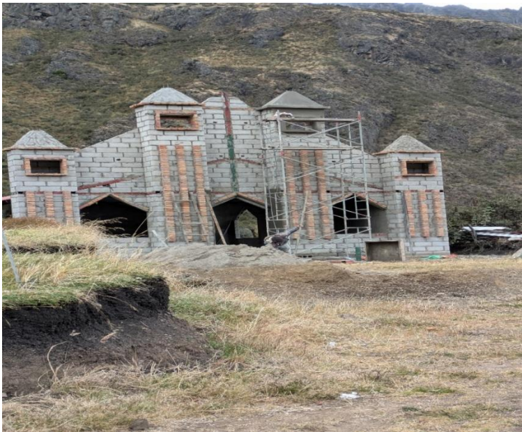
Iglesia de Patul en construcción
