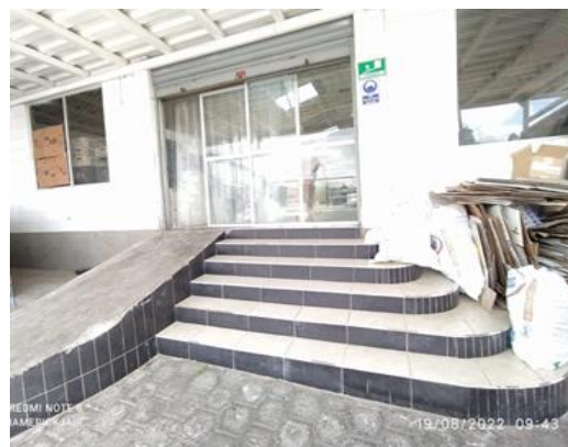
Figura 38. Gradas de ingreso sin mantenimiento.
